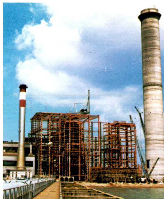
Kerja-kerja pembesaran Peringkat III — Stesen Janaelektrik Perai sedang dijalankan.
