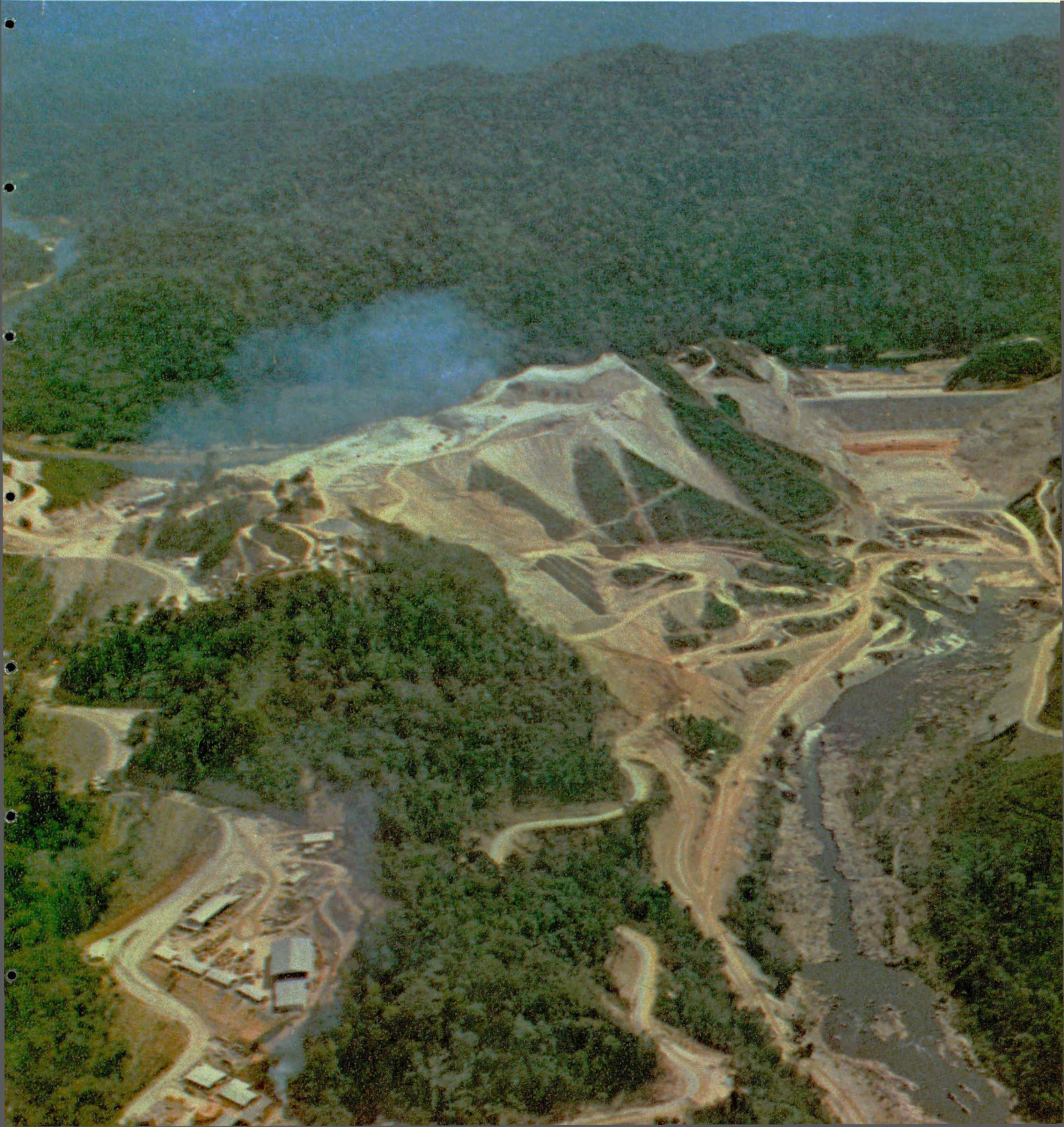
Tapakbina Empangan Temengor — Pemandangan dari Udara.
