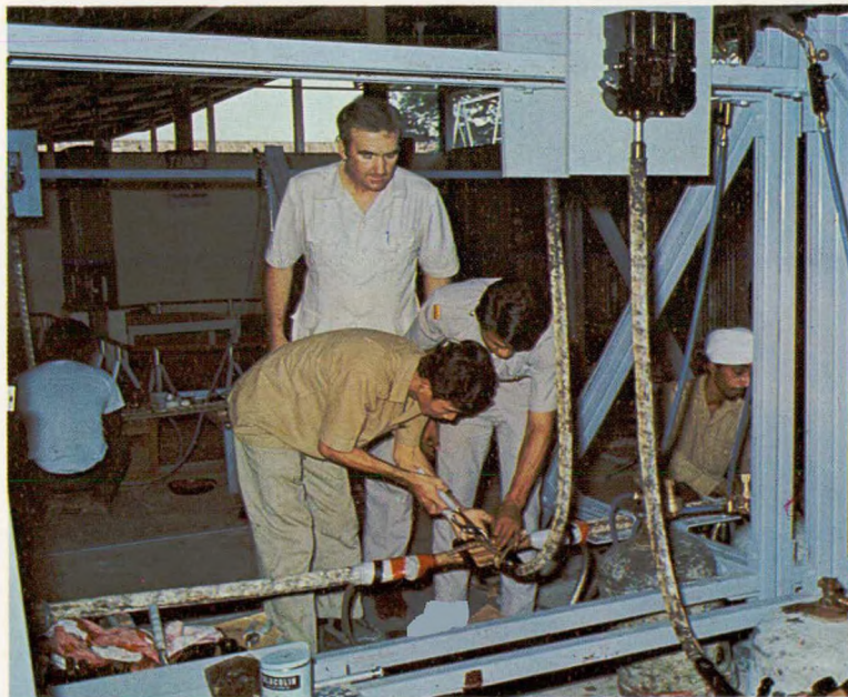
Kerja latihan bagi kebel hidup bawahtanah voltan sederhana.
