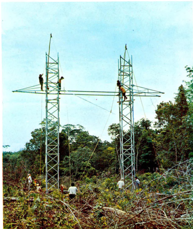
Talian Penghantaran 132 kV diantara Kuala Lumpur dan Bentong dalam Pembinaan
