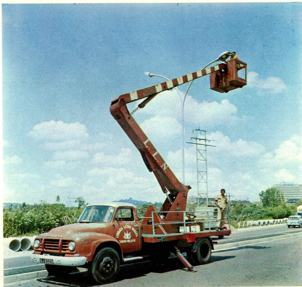
Pekerja-Pekerja sedang menjalani penyenggaraan lampu jalan di atas Kenderaan Menara di Kuala Lumpur, Selangor.
