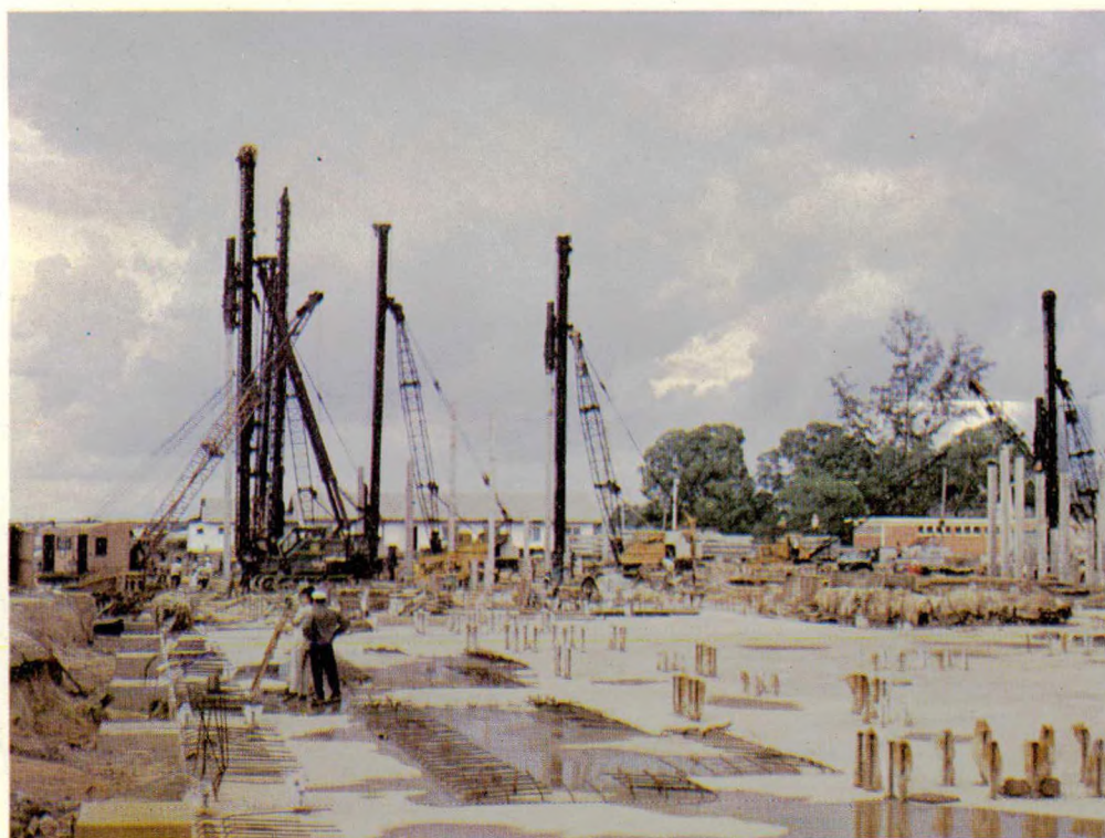
Kerja Pembentung Pam A.P. bagi Peringkat Ketiga Stesyen Janaletrik Tuanku Ja'afar, Port Dickson, Negeri Sembilan.
