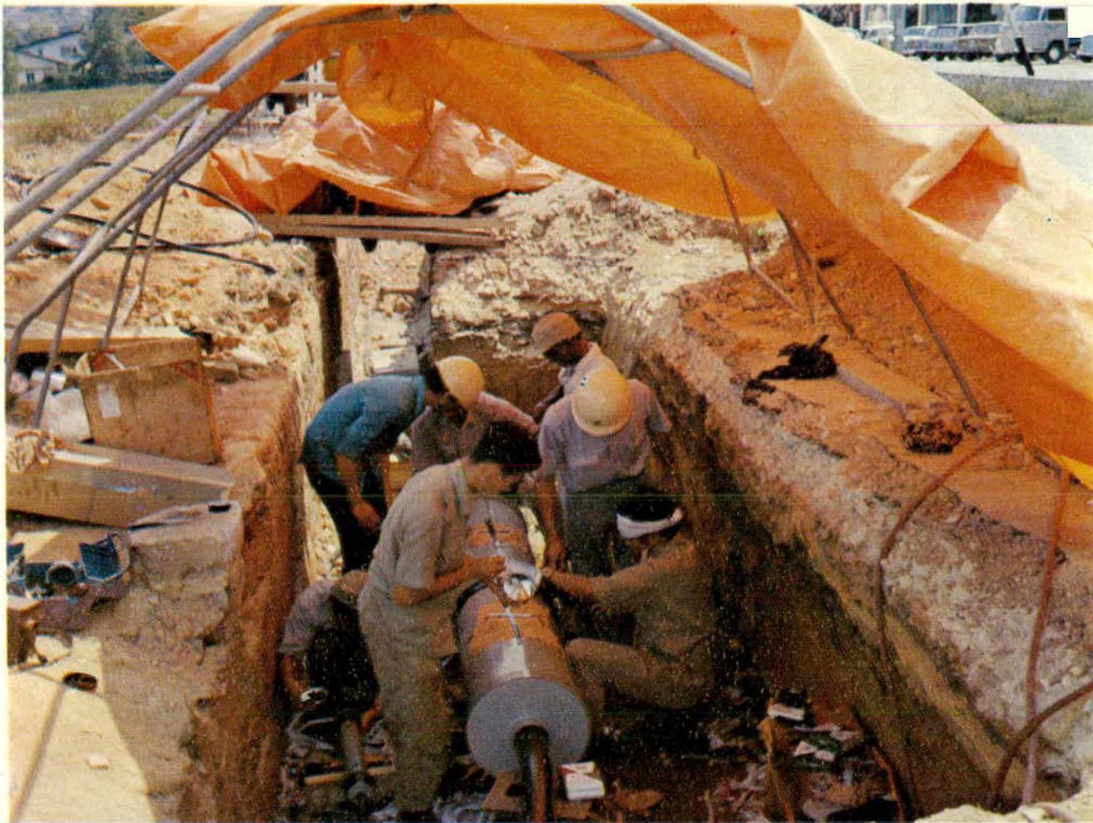
Penyambungan Kabel Bawahtanah 33kV
