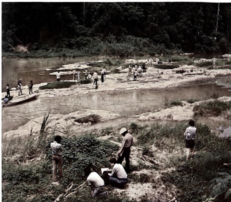
Kerja-kerja awal projek hidro-elektrik, Bersia.
