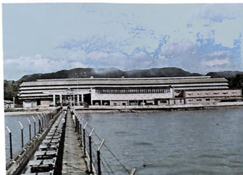
2 Stesen Janaelektrik Glugor 40 MW + 20 MW (Tarbin Gas)
