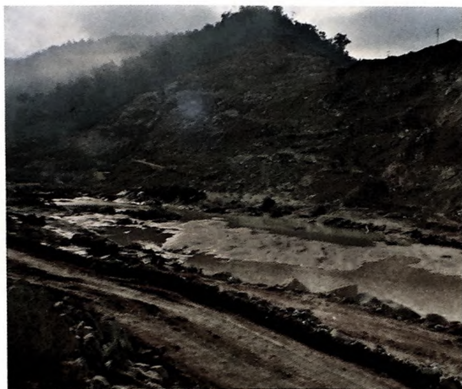
Kerja-kerja penggalian sedang giat dijalankan di tapak Projek Hidro Elektrik Kenyir, Trengganu.
