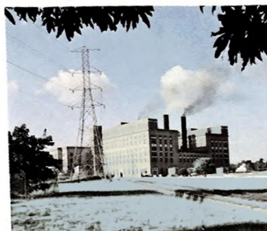
3 Stesen Janaelektrik Jambatan Connaught 80 MW + 20 MW (Tarbin Gas)
