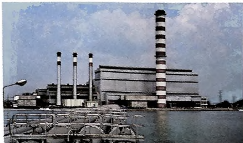
1 Stesen Janaelektrik Perai 330 MW
