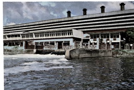
6 Stesen Janaelektrik Sultan Ismail 120 MW + 20 MW (Tarbin Gas)
