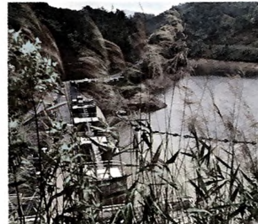
8 Stesen Janaelektrik Sultan Yussuf 100 MW
