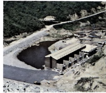
9 Stesen Janaelektrik Temengor 348 MW
