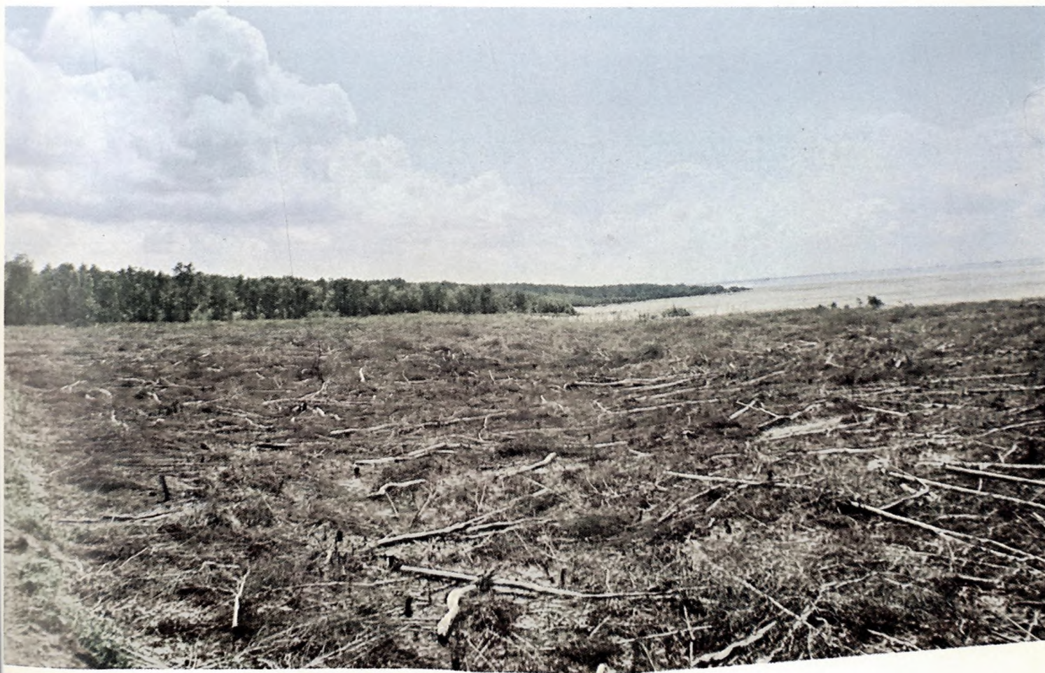
Kerja-kerja pembersihan tapak untuk Stesen Janaelektrik Pelabuhan Kelang
