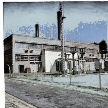
5 Stesen Janaelektrik Melaka 40 MW
