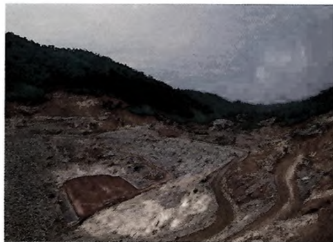
Kerja-kerja awam sedang giat dijalankan di tapakbina Projek Hidroelektrik Kenyir, di Trengganu.
