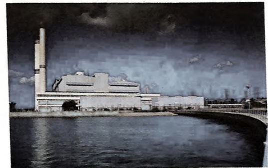
4 Stesen Janaelektrik Tuanku Ja'afar 600 MW + 20 MW (Tarbin Gas)
