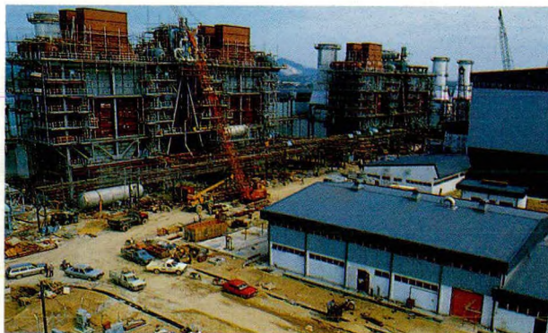
▼ Kerja-kerja pembinaan di projek Stesen Janaelektrik Paka.
