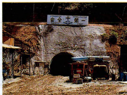
Pembinaan Projek Hidroelektrik Sungai Piah. Construction of the Sungai Piah Hydro-Electric Project.
