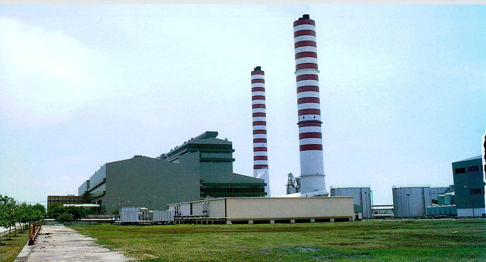
Stesen Janaelektrik Sultan Salahuddin Abdul Aziz, Kapar, Pelabuhan Kelang dimulatugas dalam tahun 1985. Sultan Salahuddin Abdul Aziz Power Station, Kapar, Pelabuhan Kelang commissioned in 1985.
