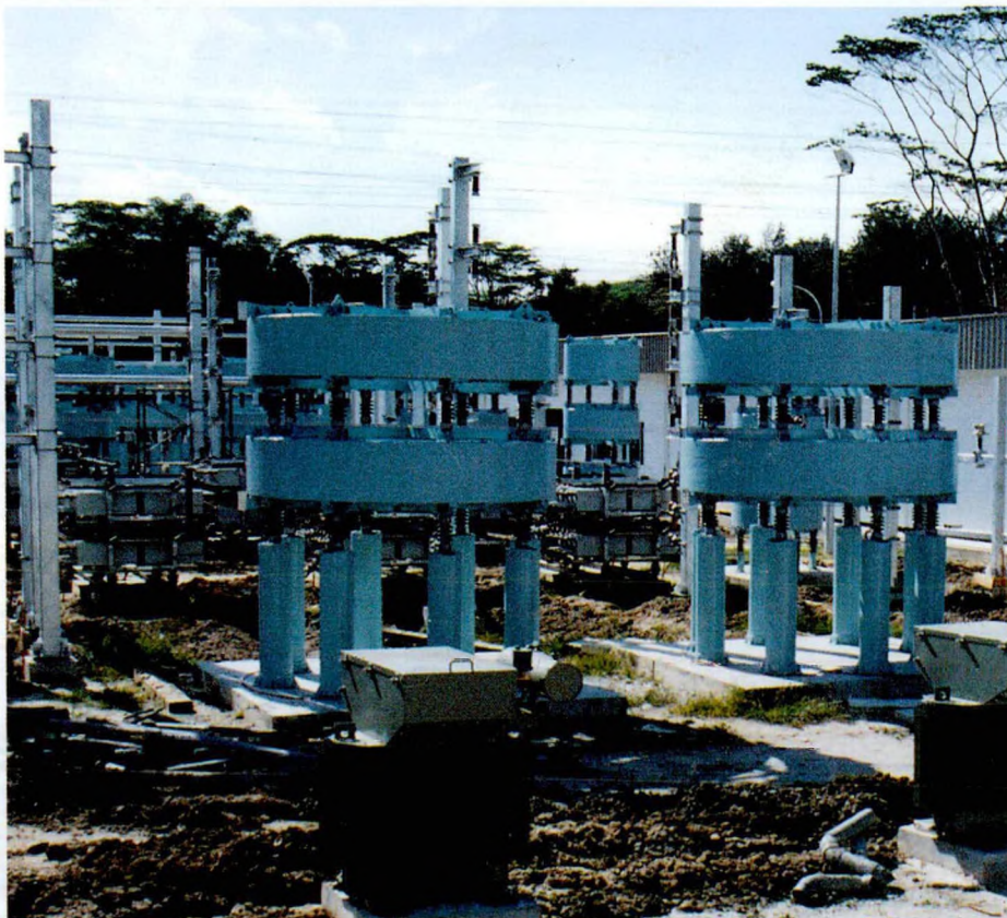
Kerja-kerja memasang SVC di pencawang Kuala Lumpur Utara.
