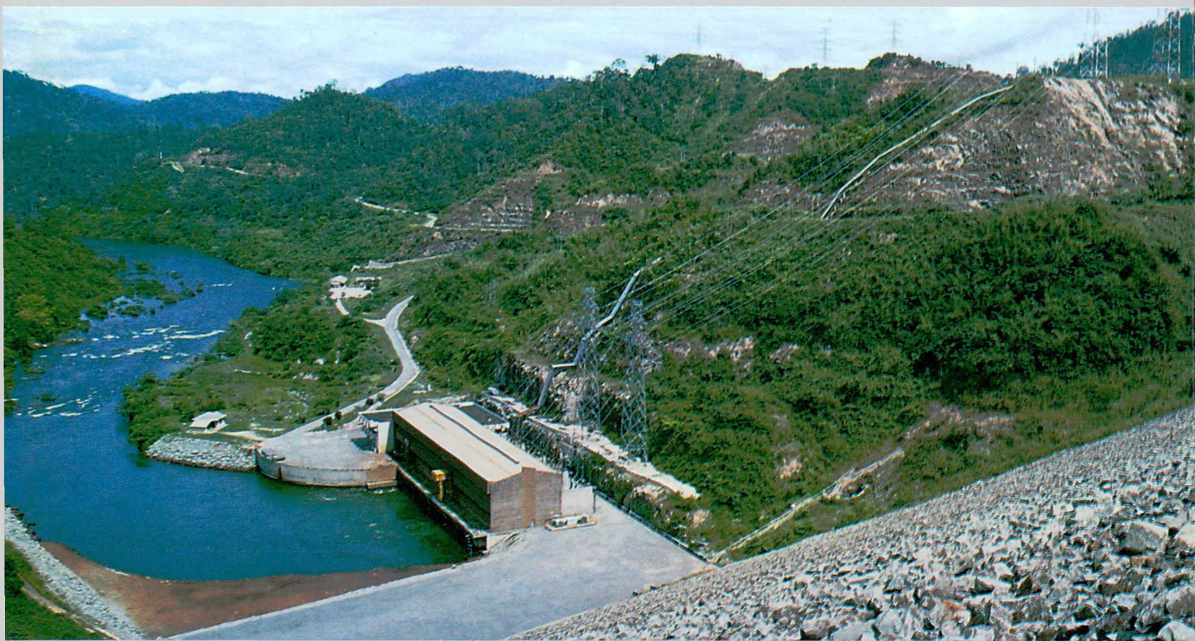
Stesen Janaelektrik Temengor dimulatugas dalam tahun 1977. Temengor Power Station commissioned in 1977.
