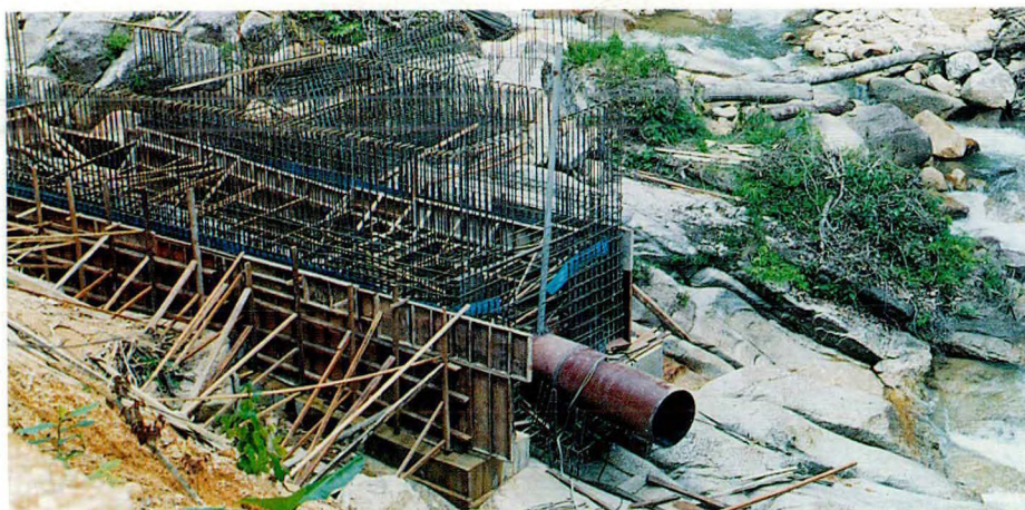
Projek mini hidro Sungai Perdak yang sedang dalam pembinaan.
