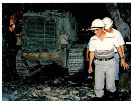
Ahli Lembaga melawat tapak bina Projek Hidroelektrik Sungai Piah.
