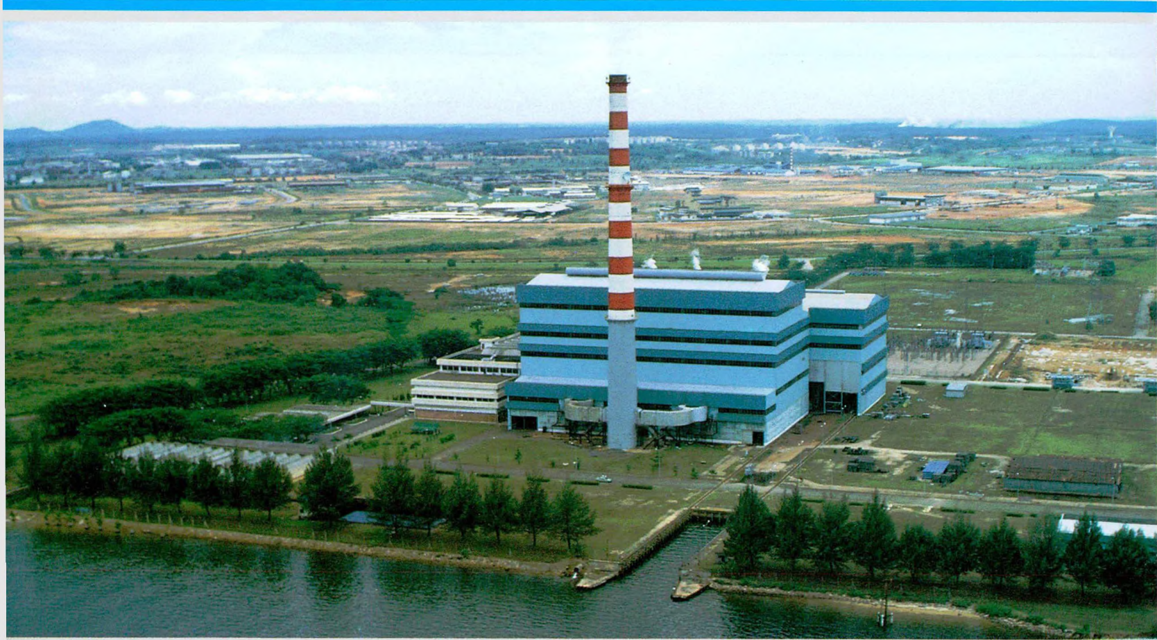
Stesen Janaelektrik Sultan Iskandar, Pasir Gudang dimulatugaskan dalam tahun 1982. Sultan Iskandar Power Station, Pasir Gudang commissioned in 1982.
